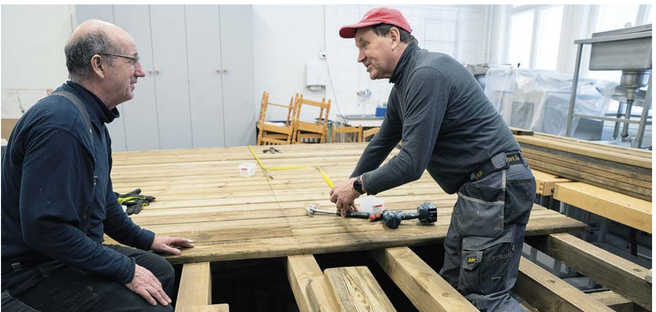
Laituri rakennettiin säältä suojassa kylätalon werstaalla. Vesa-Matti Ketolalla ja Jarmo Jyllillä on syytä hymyyn mittauksen jälkeen. Laituri mahtuu ulos werstaan ovista.
