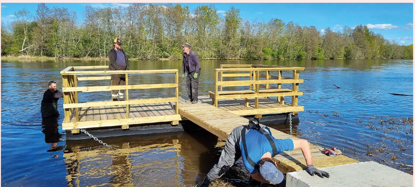
Launaistenrannan laituri on laskettu vesille. Jarmo Jylli viimeistelee laiturin kiinnitystä.
