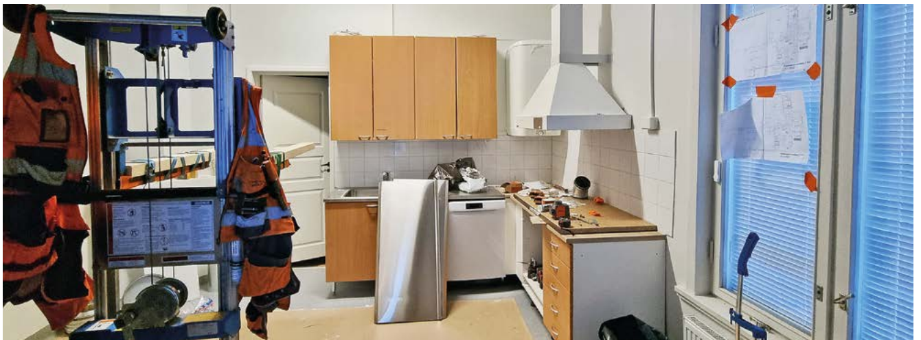
Uuden keittiön kalusteiden asennus on alkanut joulukuussa 2022.
